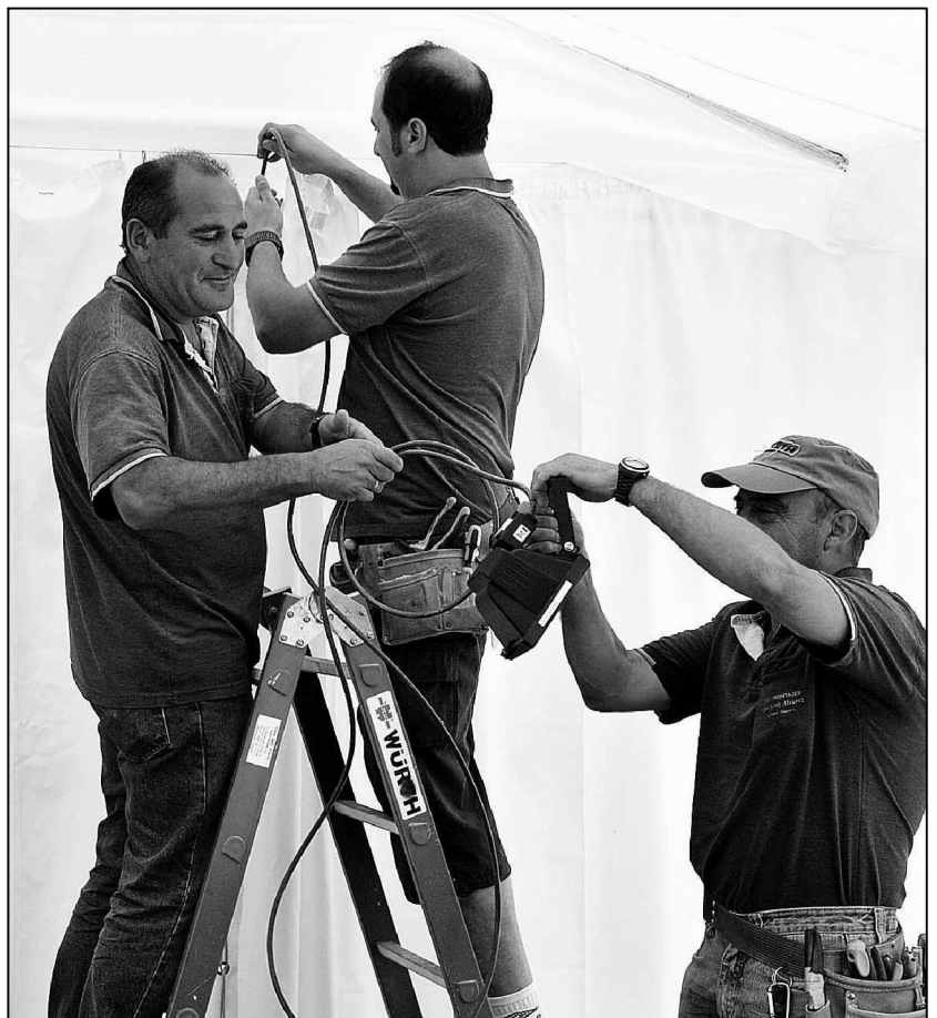
Operarios de la empresa Hermanos Álvarez colocan un cable de la luz en una de las carpas de las instalaciones.
